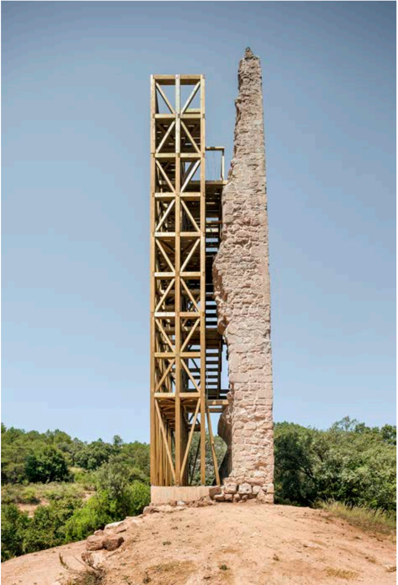
» Puig-reig Recuperació de la Torre de Merola Recovery of Merola's Tower
