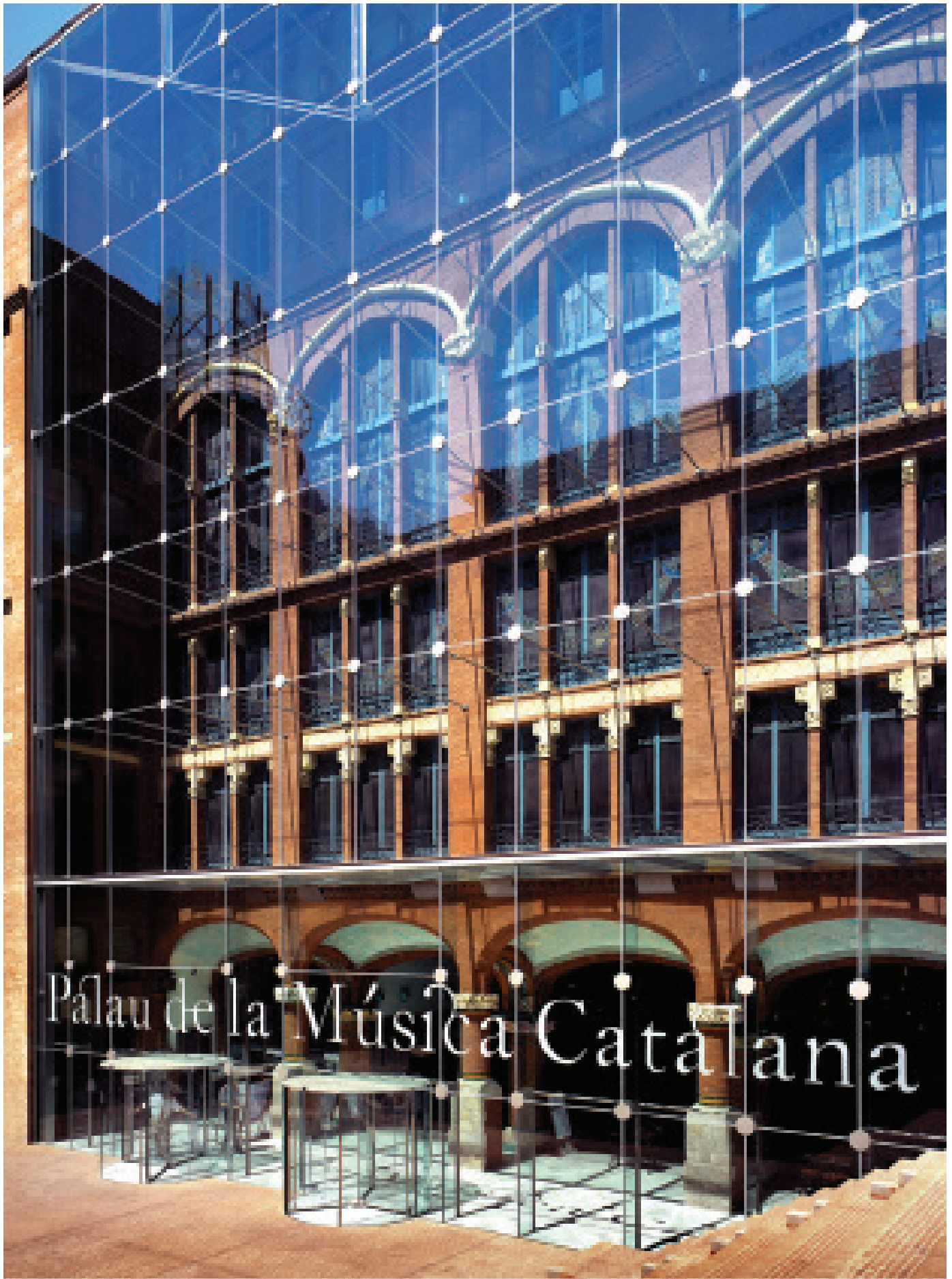
» Barcelona Petit Palau New extension of Palau de la Música
